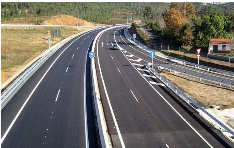
Tramo de autovía similar al del accidente (foto web: www.circulaseguro.com )
